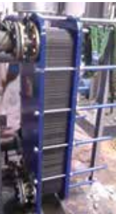
Echangeurs à plaques et joints
