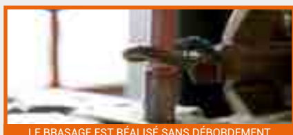
LE BRASAGE EST RÉALISÉ SANS DÉBORDEMENT
